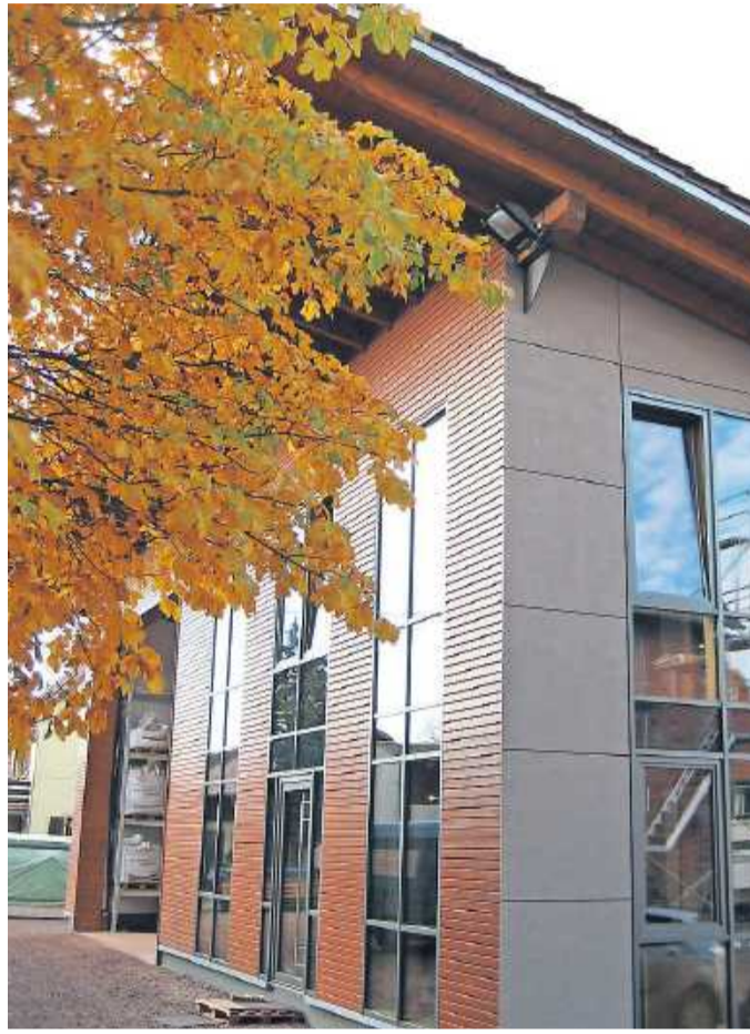
Betriebsgebäude der Firma Wissing.
